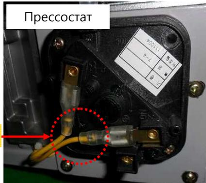
3) Короткое замыкание выключателя низкого давления и прессостата .
